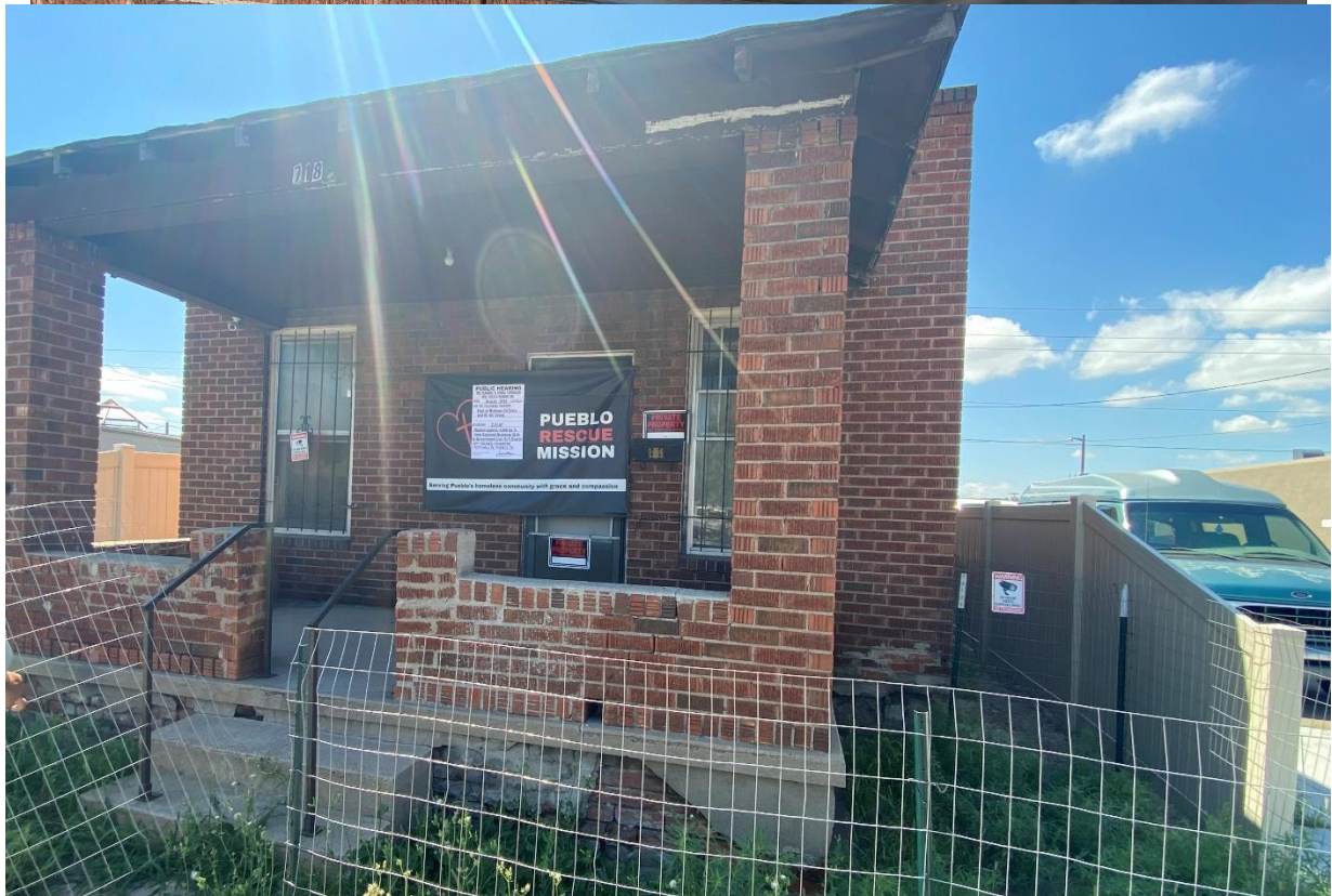
D. Site Photos, Public Notice
