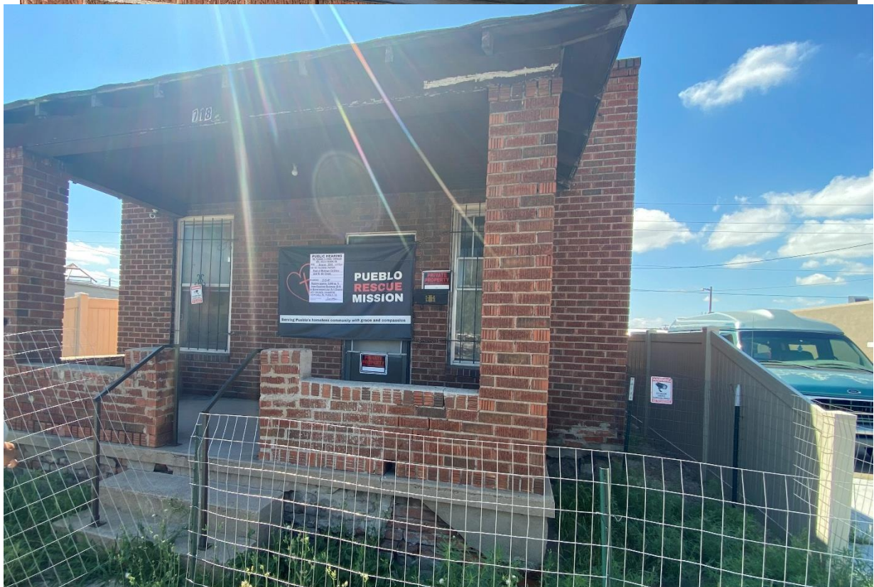
D. Site Photos, Public Notice
